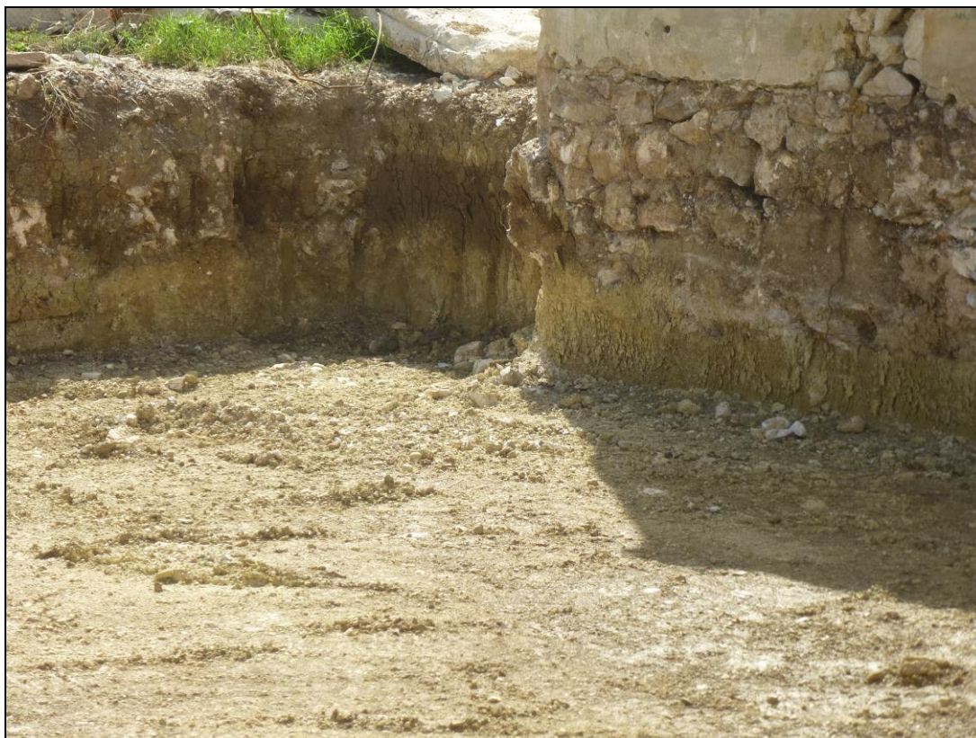
Scavo effettuato a ridosso dell'edificio limitrofo alla stalla (lato Nord-Porcilaia)
