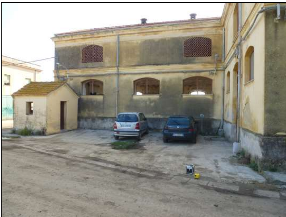
Vista della Stalla (lato Sud-Ovest) con ubicazione del punto di rilievo sismico TR1
